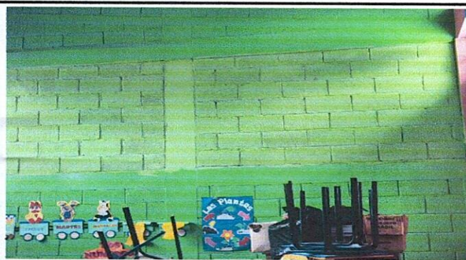
Foto 5: mejoramiento de ventanas aula 3 y 4
