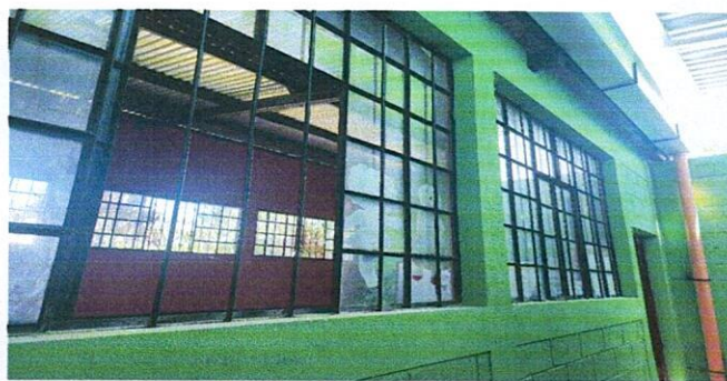
Foto 4: Mejoramiento de ventanas
