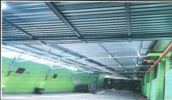
Foto1: Mejoramiento de techo, bodega, baños y patio
